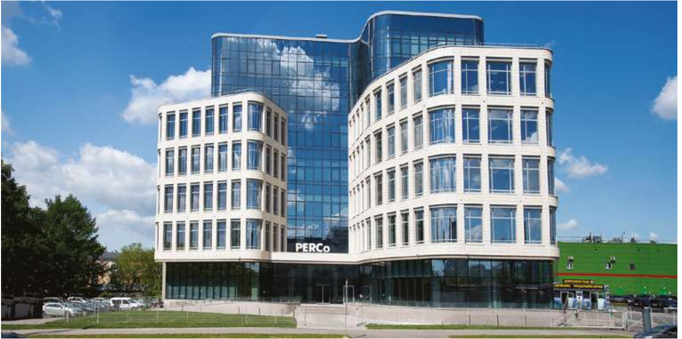
Главный офис PERCo
